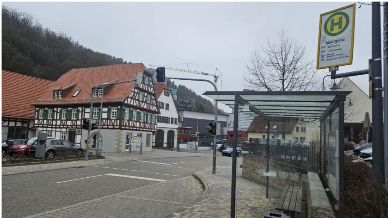
Fehlende Barrierefreiheit an einer Lichtsignalanlage / Haltestelle in Mönsheim (Eigene Darstellung)
